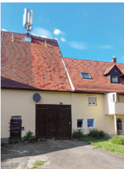
△ Die Antenne steht auf einem ehemaligen Stall, dem höchsten Gebäude im Dorf.
